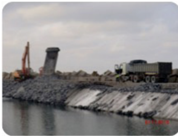
Construcción de los recintos (Fuente: Autoridad Portuaria de Huelva)
