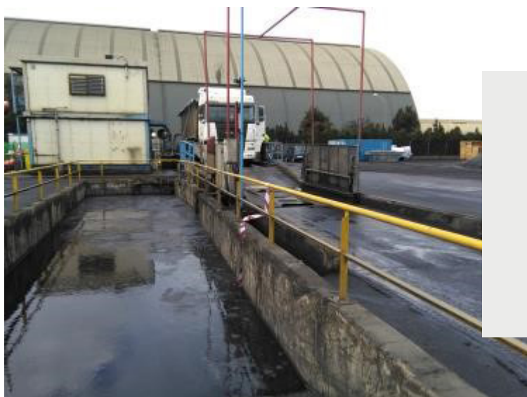
Balsa para la recogida de aguas de lavado
