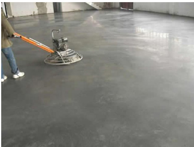
Pavimento de hormigón pulido (Fuente: aplikamolina.com)
