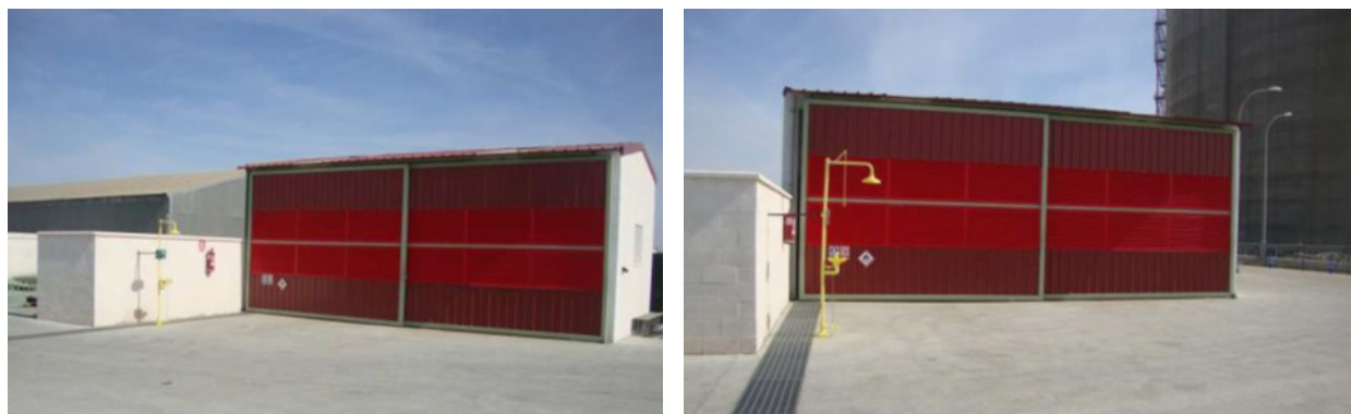
Nave almacén de pinturas y productos inflamables
