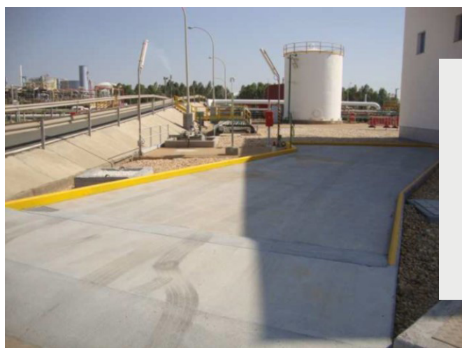
Nuevo tanque y cubeto de recogida de gasoil
