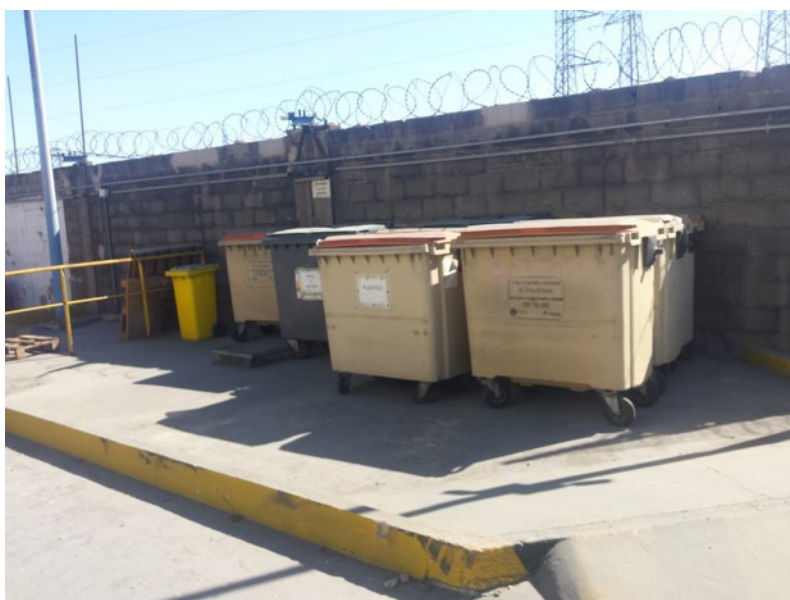
Zona habilitada para la recogida selectiva de residuos no peligrosos (Fuente: Air Liquide Ibérica de Gases, S.L.U.)
