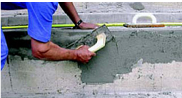
Proceso de reparación e impermeabilización
