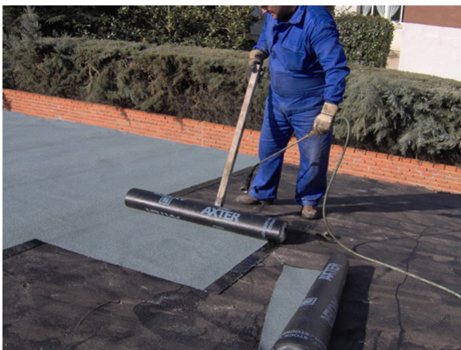
Impermeabilización de superficies con membranas asfálticas (Fuente: www.asfalto-rc250.blogspot.com )
