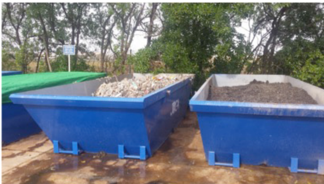
Cubas de detritus y arenas generados en la E.D.A.R. (Fuente: Empresa Municipal de Aguas de Huelva, S.A.)
