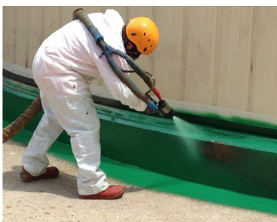
Proceso de reparación e impermeabilización
