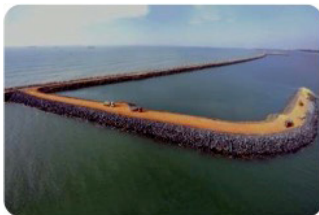
Técnica de confinamiento en recintos (Fuente: Autoridad Portuaria de Huelva)
