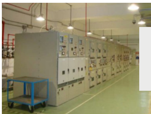
Iluminación Led en subestaciones eléctricas
