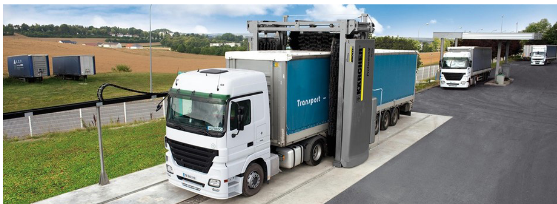
Lavadero de camiones con sistema de recogida central (Fuente: www.autolavaggi-usati.it )
