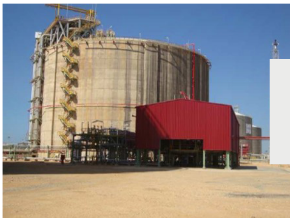
Compresor de recuperación BOIL-OFF
