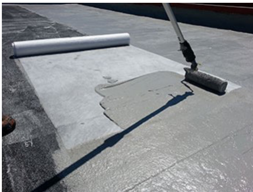
Impermeabilización de suelos (Fuente: www.impas.es )
