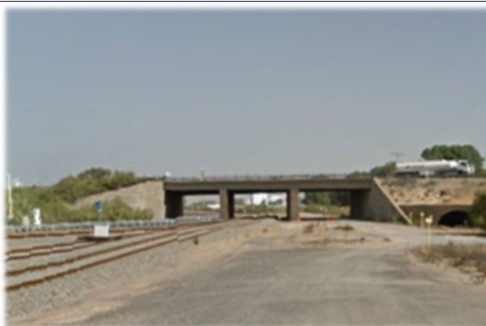
Paso Superior de la carretera N-442
