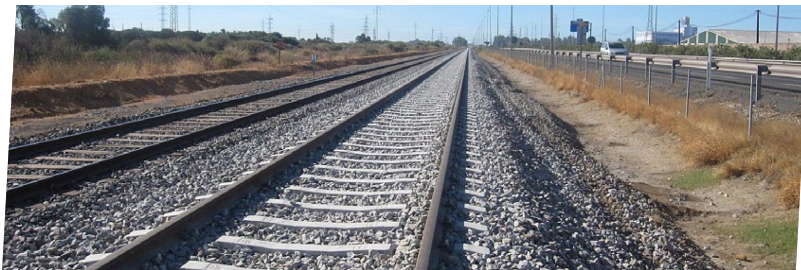
Obras del enlace ferroviario entre el Paseo de las metas y el puente del Tinto.
