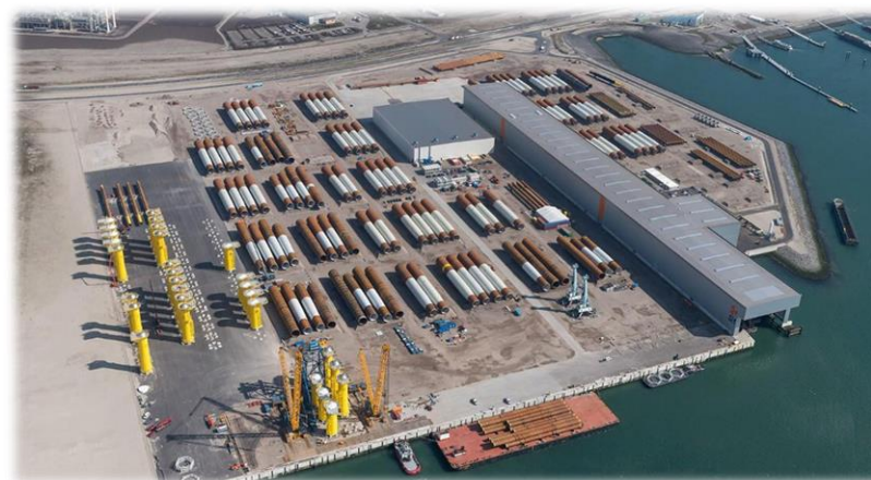
Terminal de fabricación y embarque de monopilotes
