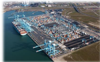
APMT en Maasvlakte2, Rotterdam. Una terminal totalmente automatizada basada en operaciones convencionales.
