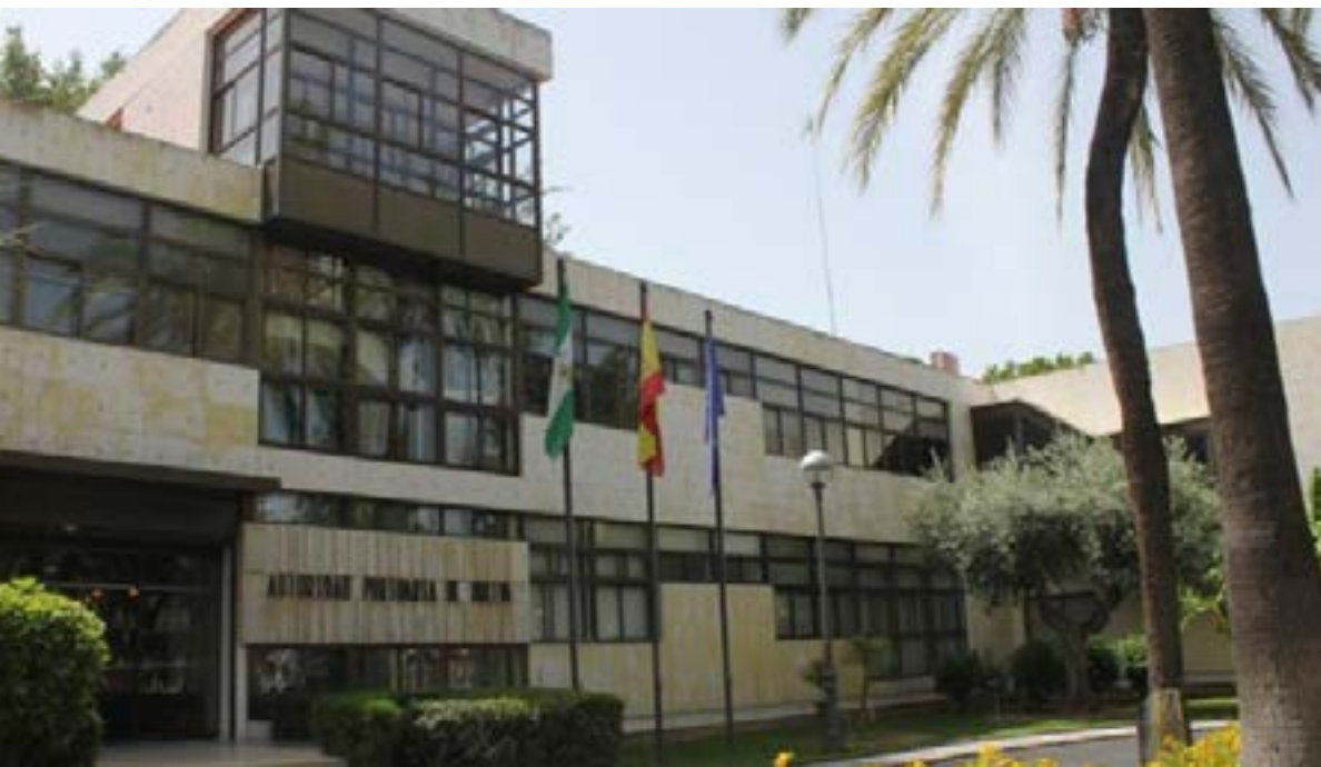
Oficinas de la Autoridad Portuaria de Huelva
