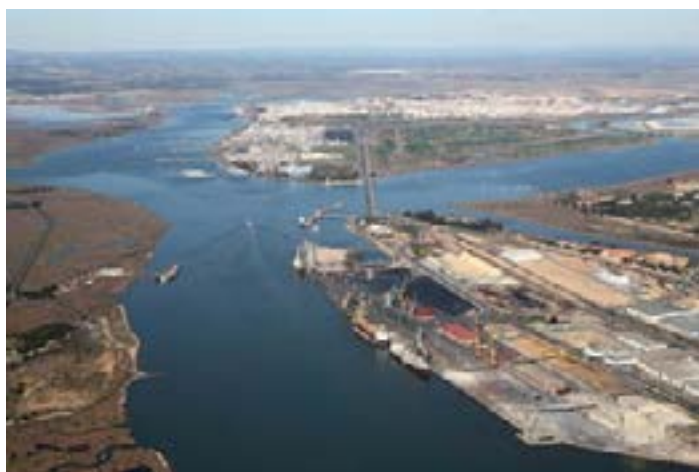
Vista aérea oblicua de los muelles afectados, con la ampliación sur del muelle Ing. J. Gonzalo en primer término.
